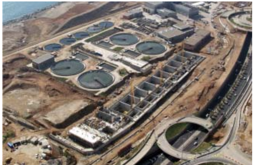
Obras 1ª fase. En primer término el nuevo tratamiento primario en ejecución
