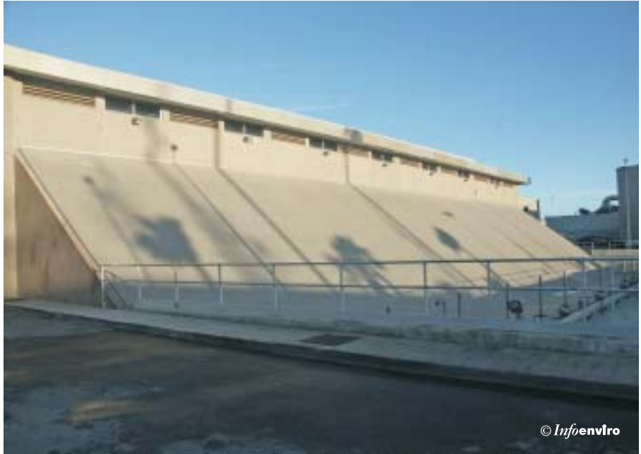
Cubierta de los tornillos de Arquímedes
